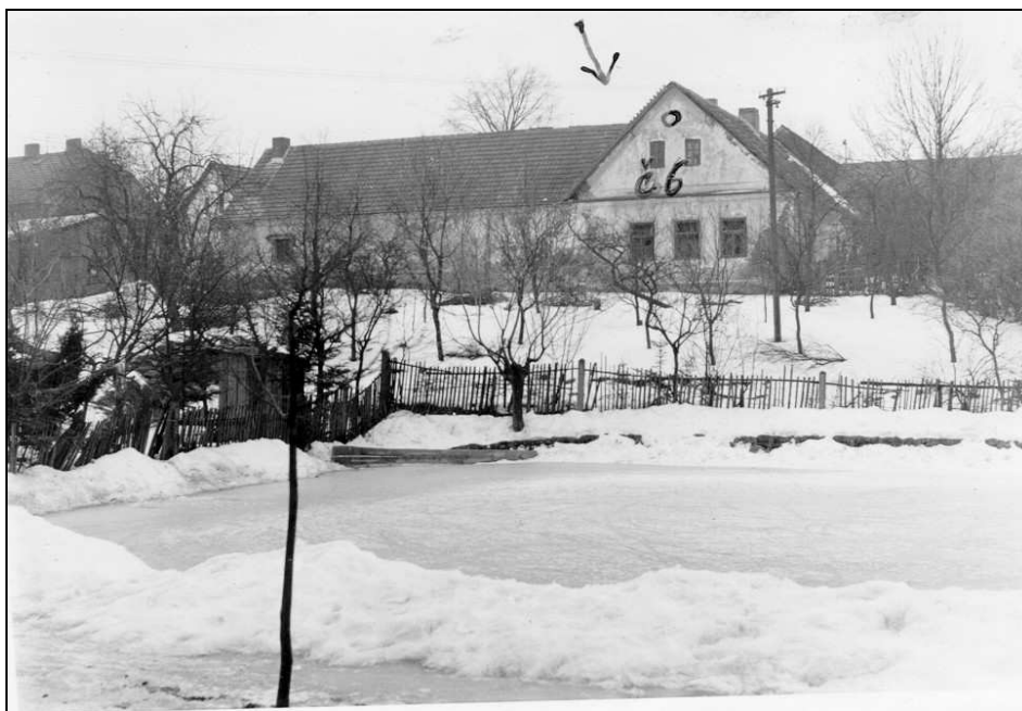
Bývalý statek žida Steina, který byl v roce 1923 ve veřejné dražbě rozprodán. Nový majitel Antonín Kerouš na něm hospodařil do roku 1952, kdy bylo jeho hospodářství likvidováno.
