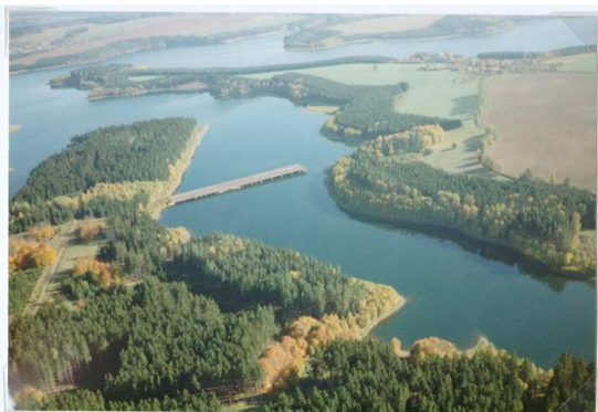
Přehrada Želivka- starý dálniční most
