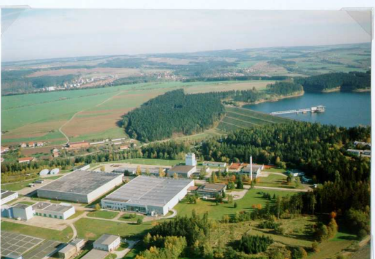
Přehrada Želivka-hráz,Vodárna Želivka
